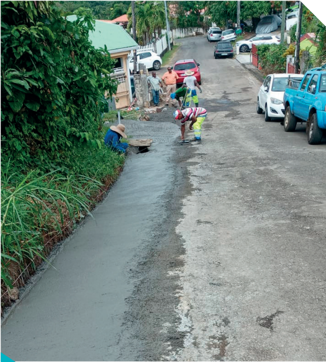
Accotement et canalisation des eaux pluviales à Augrain Sud
