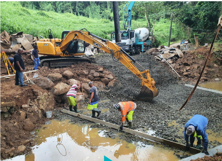
Réfection du pont quartier La Haut
