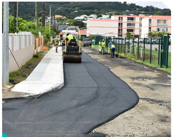
Refection de l'allée des Amandiers du quartier Cité Mansarde 1
