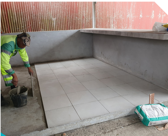
Construction d'une deuxième buvette au stade Léon Duchamps du Vert-Pré
