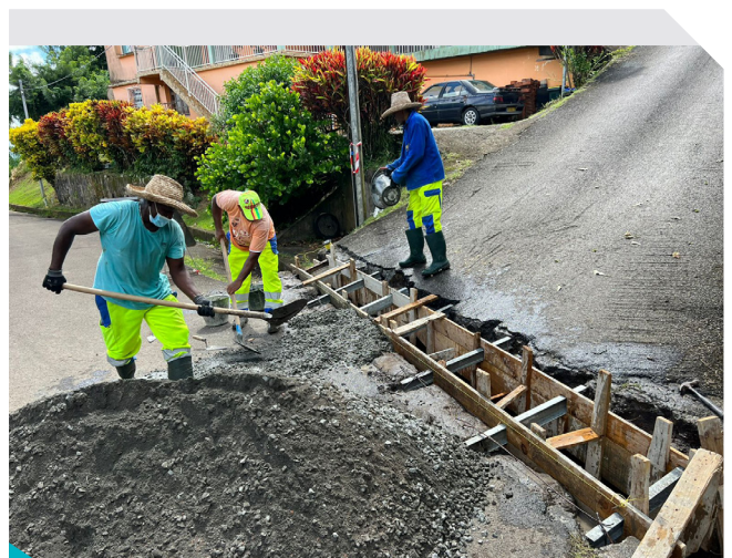
Travaux allée des Amandiers à Cité Mansarde
