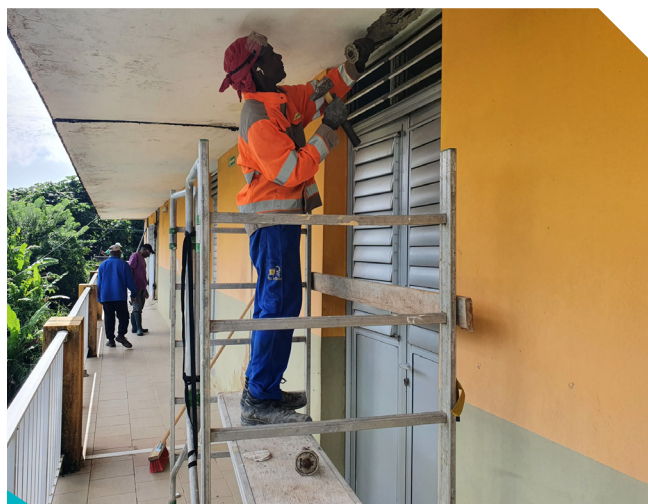
Travaux à l'école « Robert Platon » de Duchesne
