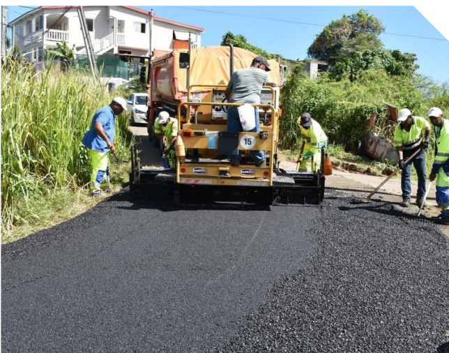
Travaux d'enrobé au quartier Lazaret
