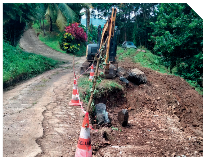
Réfection d'un chemin à Moïse
